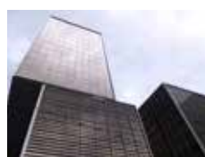
SEDE CUATRECASAS Barcelone (Spain)
