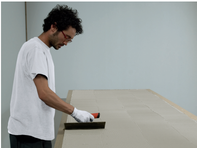
3- Extender el adhesivo, en cada ocasi n, solamente sobre la superficie de soporte sobre la que se va a colocar la pieza, no aplicar sobre superficies mayores de soporte para evitar perdidas de adherencia.
