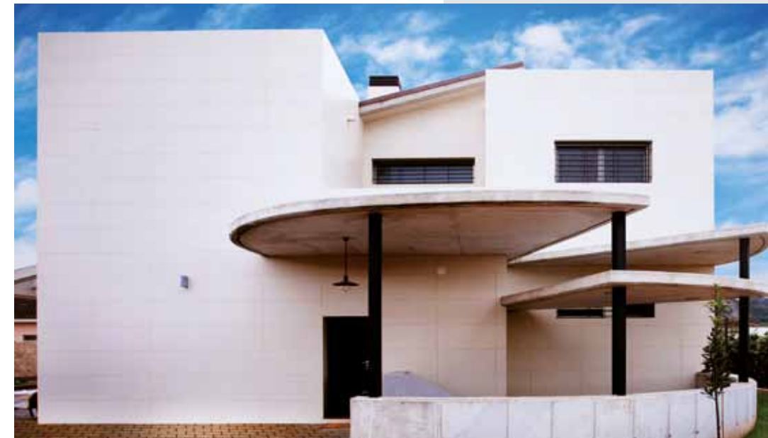
EINFAMILIENHAUS HABITATION PRIVÉE SANTOMERA, MURCIA. ESPAÑA ARCHITEKT / ARCHITECTE JOSÉ MANUEL ANDÚJAR VILLAESCUSA
