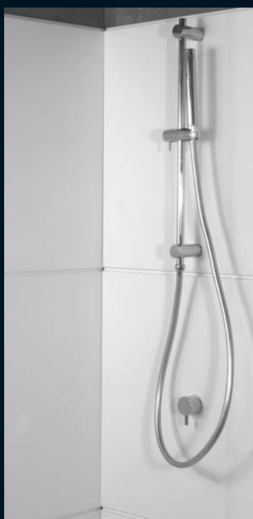
h-3 detalle grifería empotrada + kit de ducha
