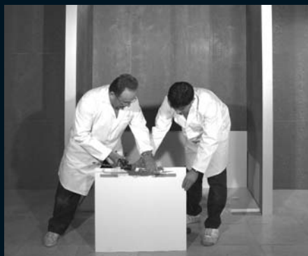
14. siliconamos panel corto y fijamos con adhesivo a dos caras
