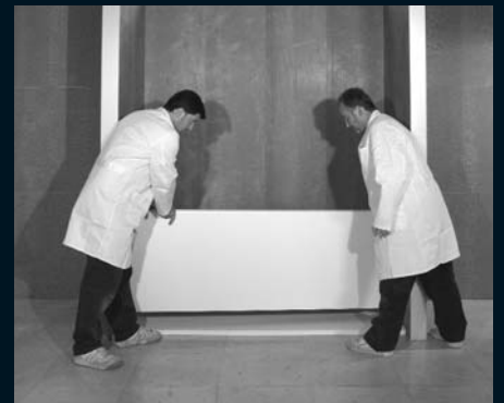
12. colocamos panel largo para cubrir la falta de azulejo
