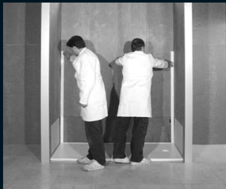
10. colocamos juntas antihumedad (al plato y a pared)
