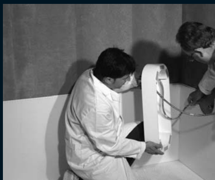
19. conectamos latiguillos y comprobamos posibles fugas
