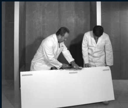
11. siliconamos panel largo y fijamos con adhesivos a dos caras
