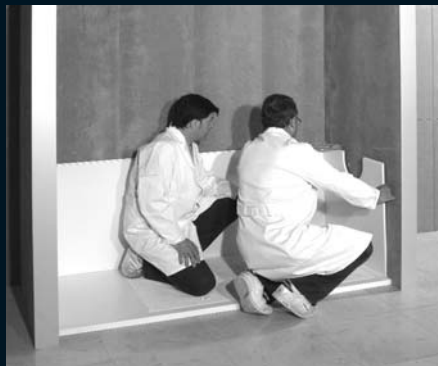
17. nivelamos y acoplamos panel corto de grifería cubriendo falta de azulejo
