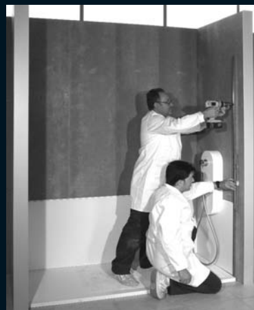
21. nivelamos e instalamos la mampara de cierre
