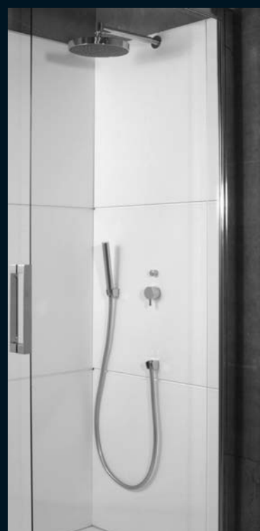
h-3 detalle grifería empotrada + rociador superior
