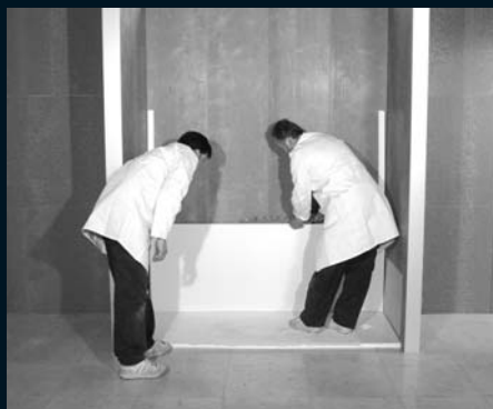
13. acoplamos panel largo y nivelamos
