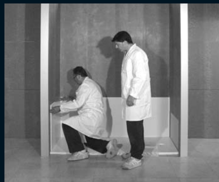
15. nivelamos panel corto para cubrir la falta de azulejo
