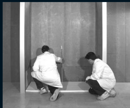
9. nivelamos en pared
