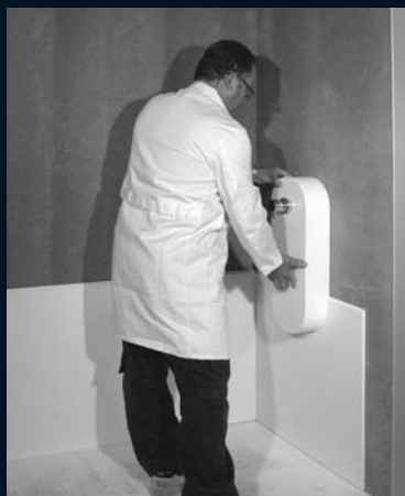
20. acoplamos caja de grifería
