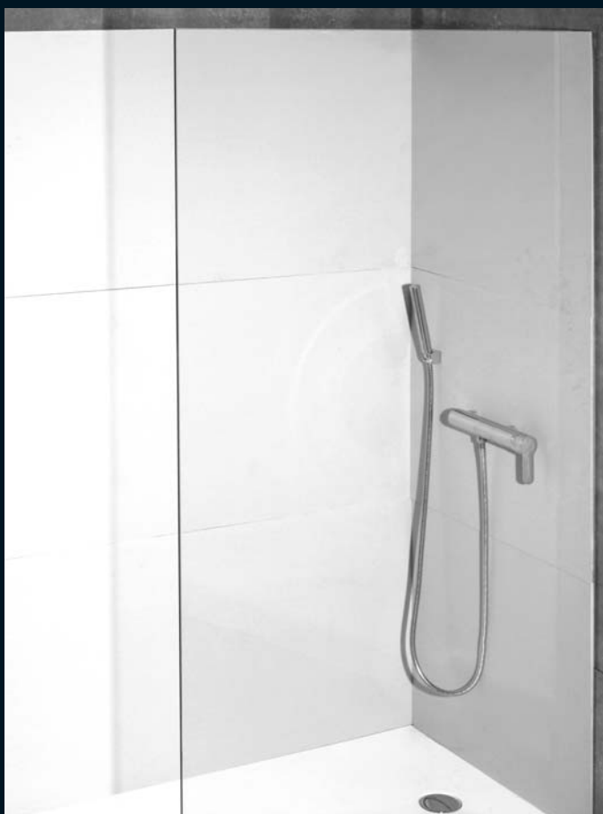
h-3 detalle panel porcelánico de 3mm beige con grifería externa de ducha
